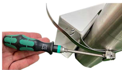
図14：ストラップを締める
