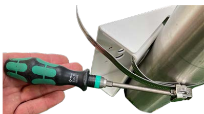
図13：ストラップの締め付け
