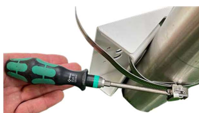
図14：ストラップを締める
